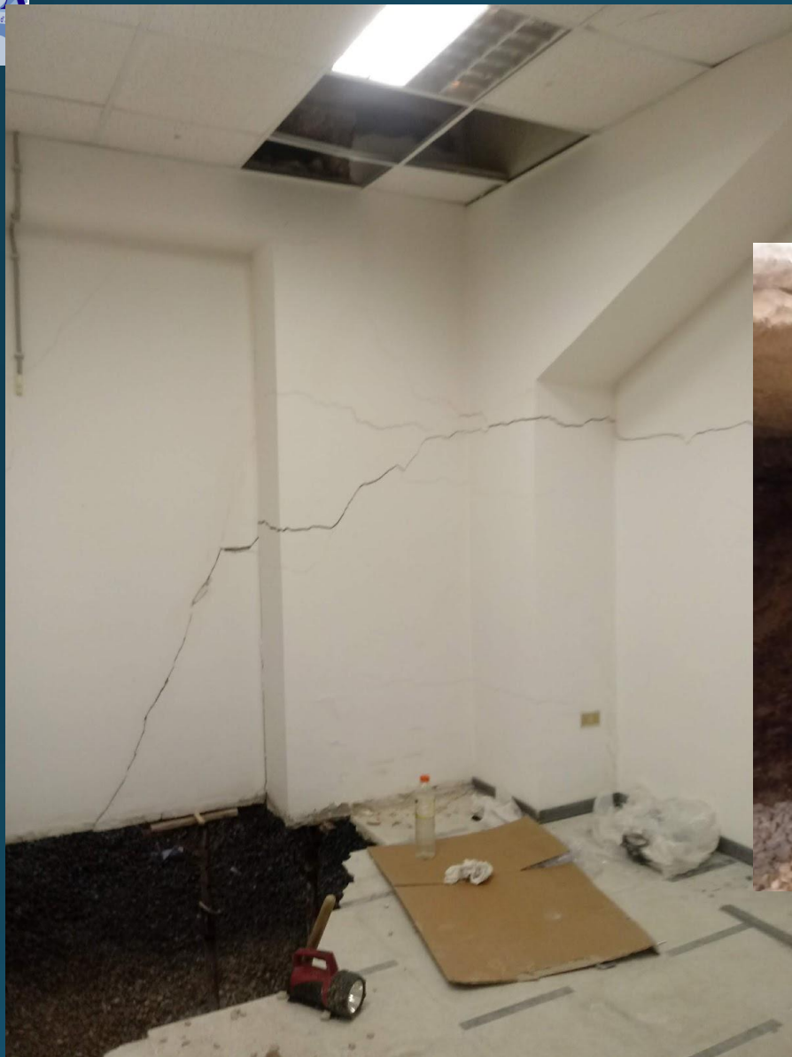
Particolari delle lesioni e dei dissesti di un fabbricato di Corso Trento e Trieste
