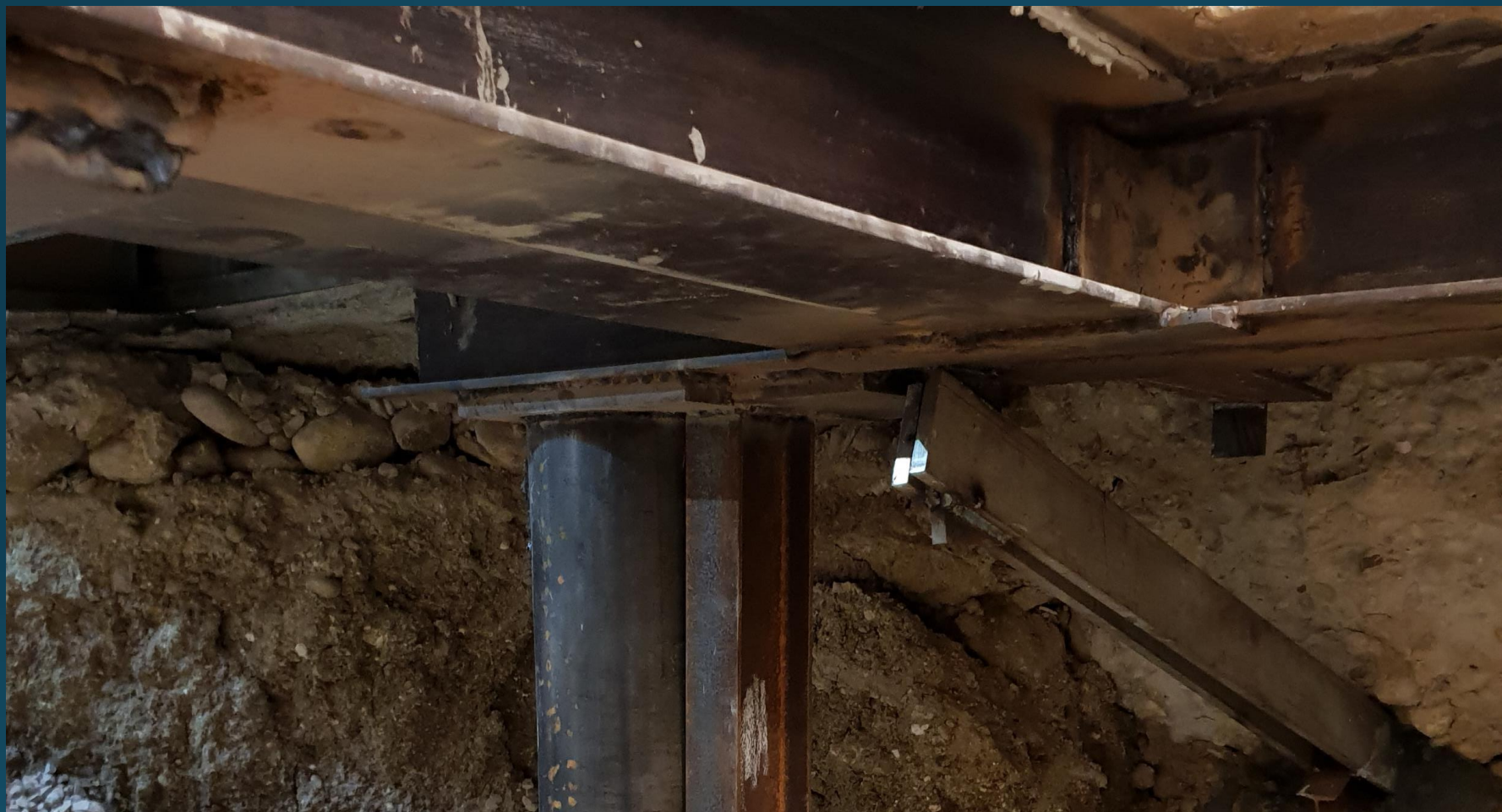
Opere di sottofondazione fabbricati Corso Trento e Trieste (immagine fornita dal dott. Geol. Luigi Carabba)
